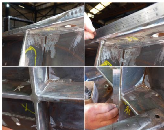
FIGURA 13. Correção da redução localizada. Fonte: Autor (2023).
