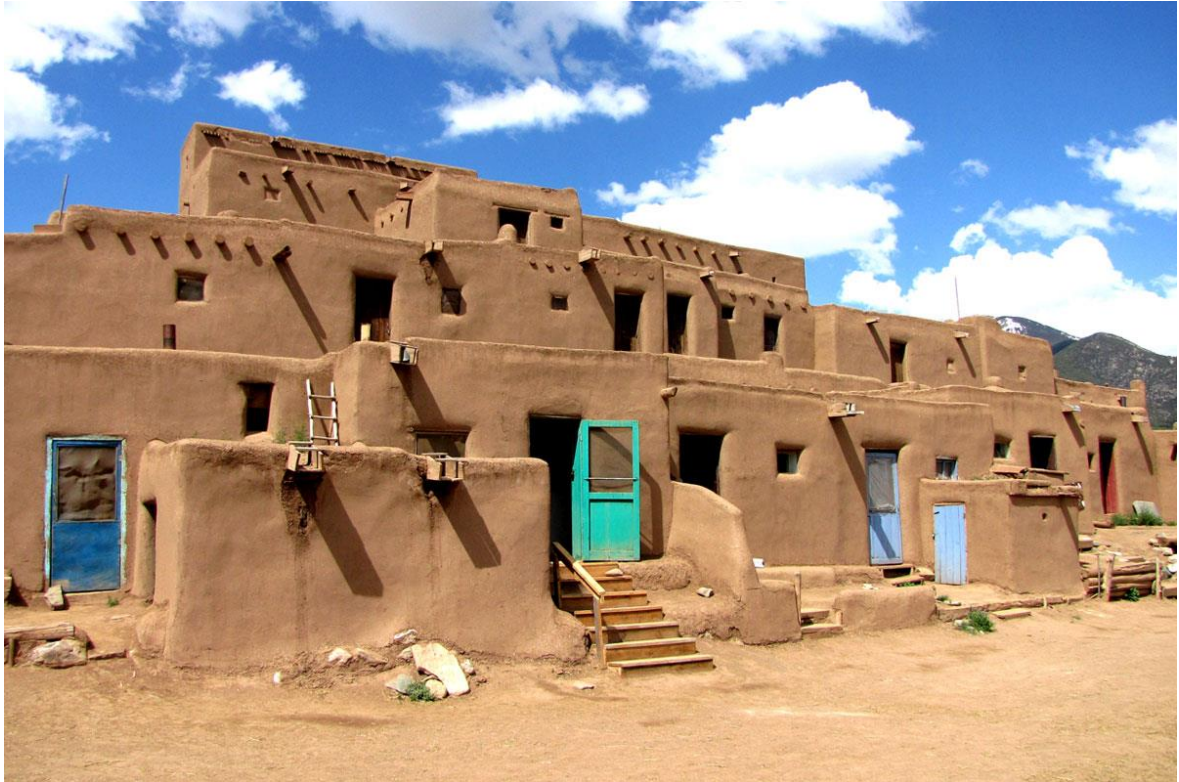
Taos Pueblo - construções feitas com adobe (imagem disponível em: < http://taospueblo.com/ > último acesso: 16/09/2017)
