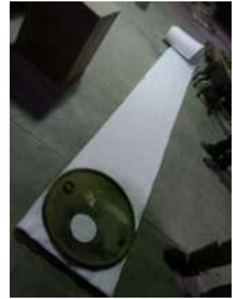
Figura 1: a) Faz-se o corte no latão em 1/3 do tamanho total; b) Fazem-se furos na tampa e nas laterais para atravessar o arame para ser amarrado; c) Corta-se a manta com o diâmetro da tampa do latão e mede-se o comprimento da manta em relação à parede. Aproximadamente 1,8m.
