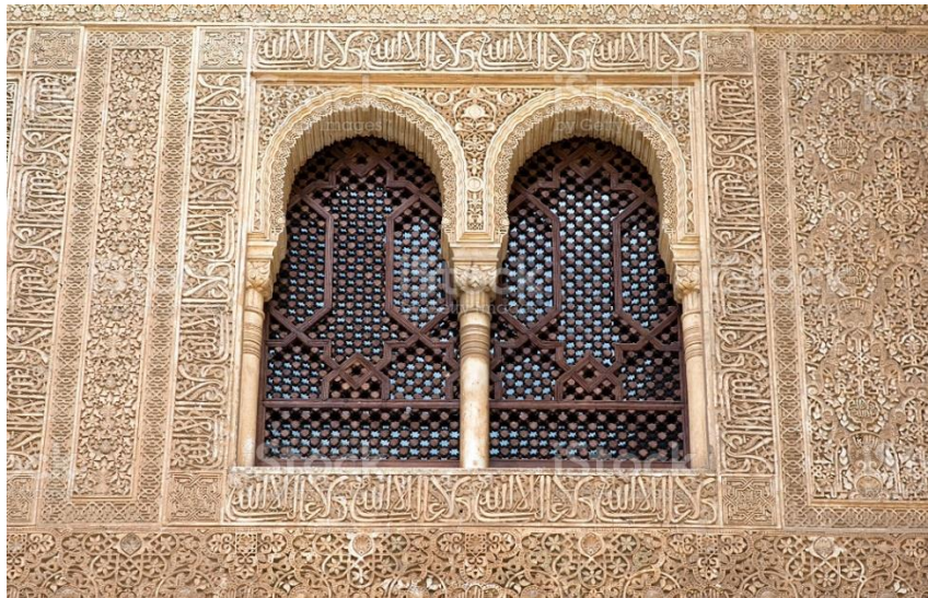
Figura 18: Janela de Alhambra: Vazados entre madeira e alvenaria.
