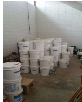
Armazenamento inadequado, diretamente no chão, sem utilização de pallet's
