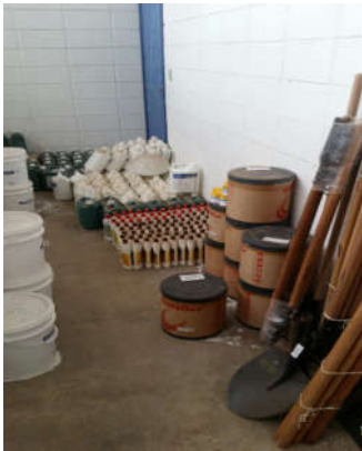
Armazenamento inadequado, diretamente no chão, sem utilização de pallet's
