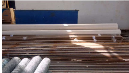
Armazenamento inadequado das ferragens
