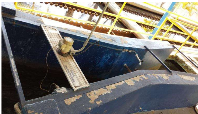
Figura 1: Calha Parshall, Estação de Tratamento de Água de Itabirito - MG
