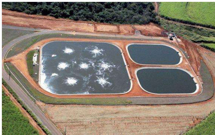
Figura 6. Lagoa Aerada, (ETE Município de Tambaú, SP).
