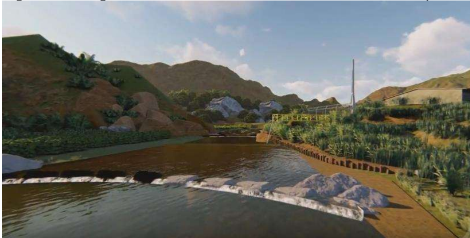
Figura 11: Degraus transversais utilizando enrocamento de pedras
