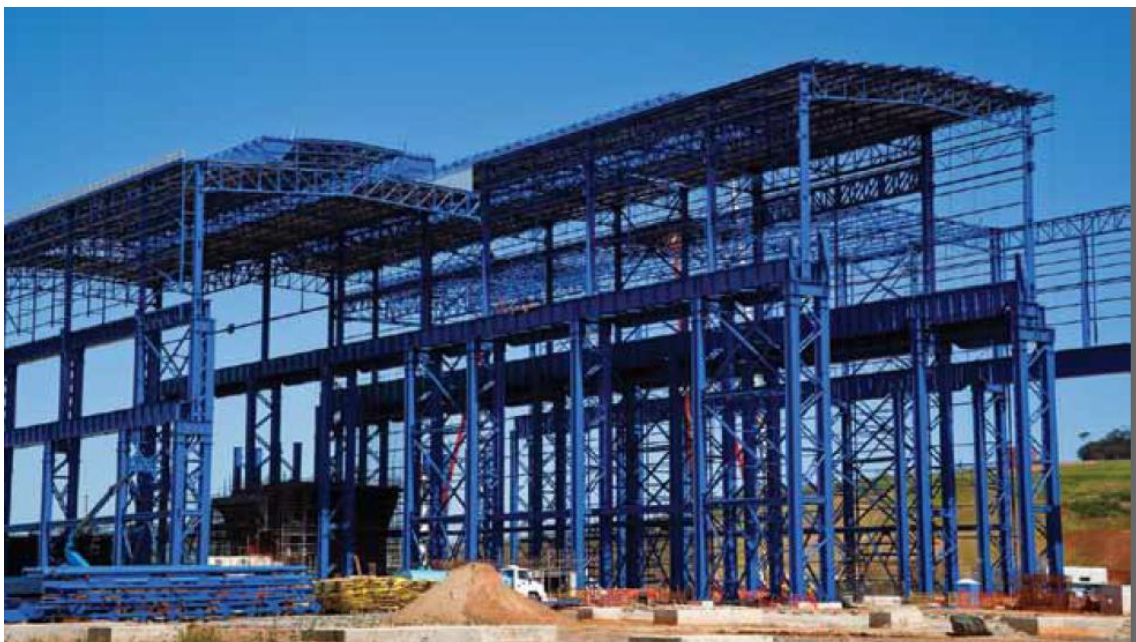
Figura 3 – Primeira aciaria do mundo em estrutura tubular
