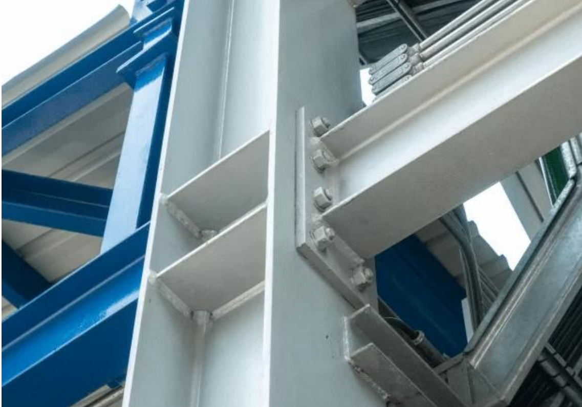
Figura 1 – Estrutura em aço em perfil aberto
