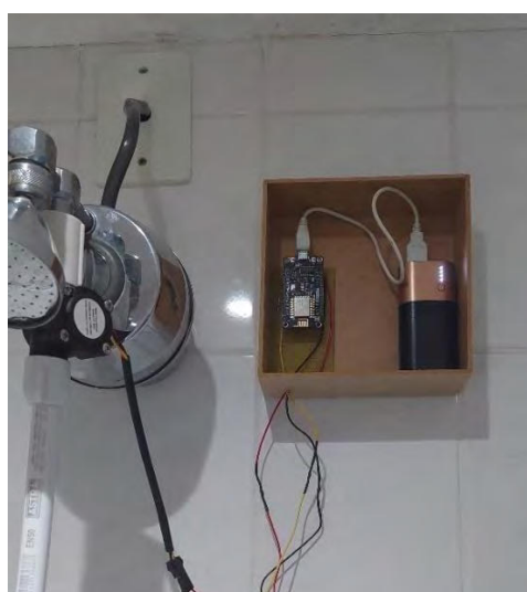
Figura : 19 - Instalação do medidor junto ao chuveiro
