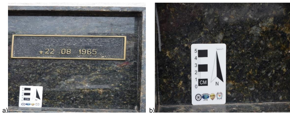
Figura 05: Charnockquito (Granito verde) utilizado nos jazigos. b) Detalhe da granulação grossa na matriz dos Charnockquitos, com presença de minerais esverdeados e Feldspatos escuros.
