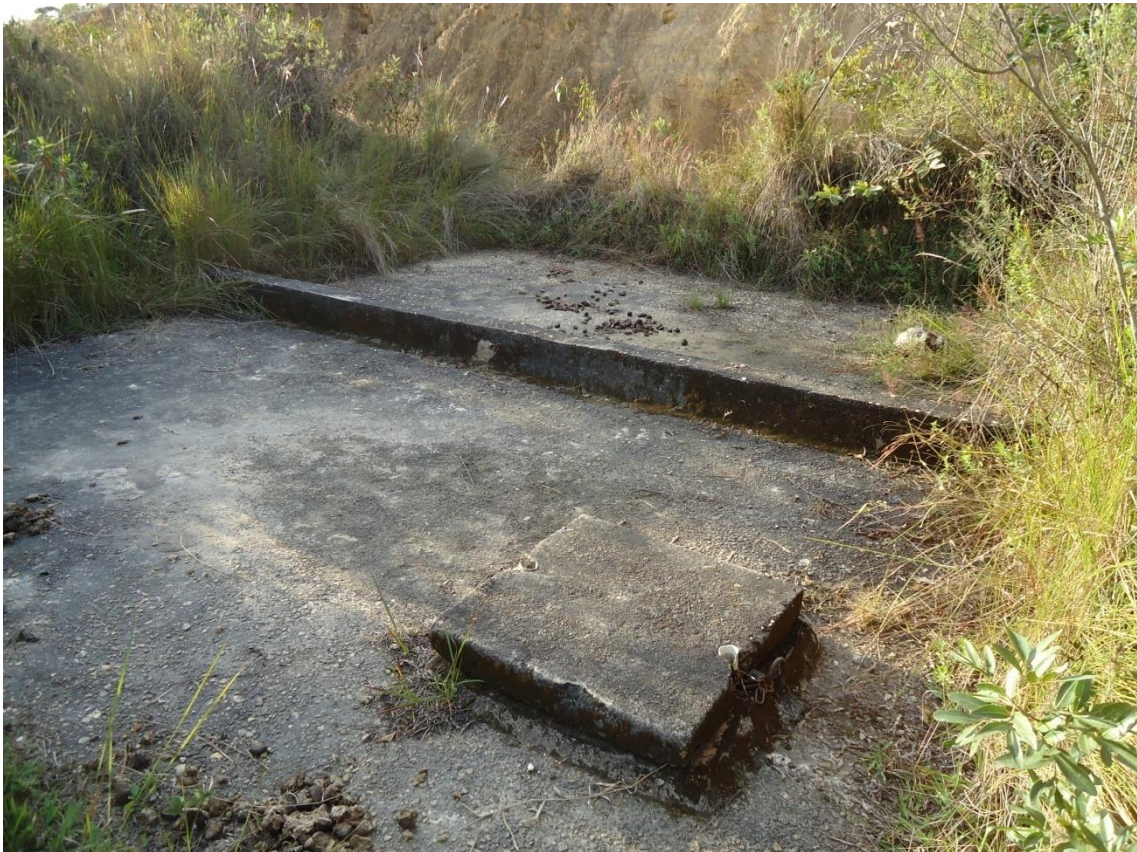
Figura 4- Reservatório de água que abastece o Município de Santa Cruz de Minas. Fonte: João Pedro do Carmo Nascimento
