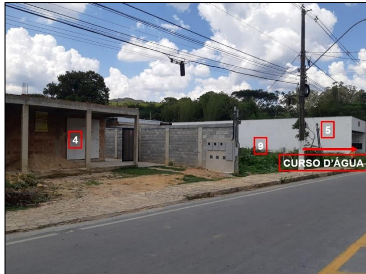
Figura 9 – Área designada vista do eixo da Avenida Ministro Gabriel Passos sentido Sul
