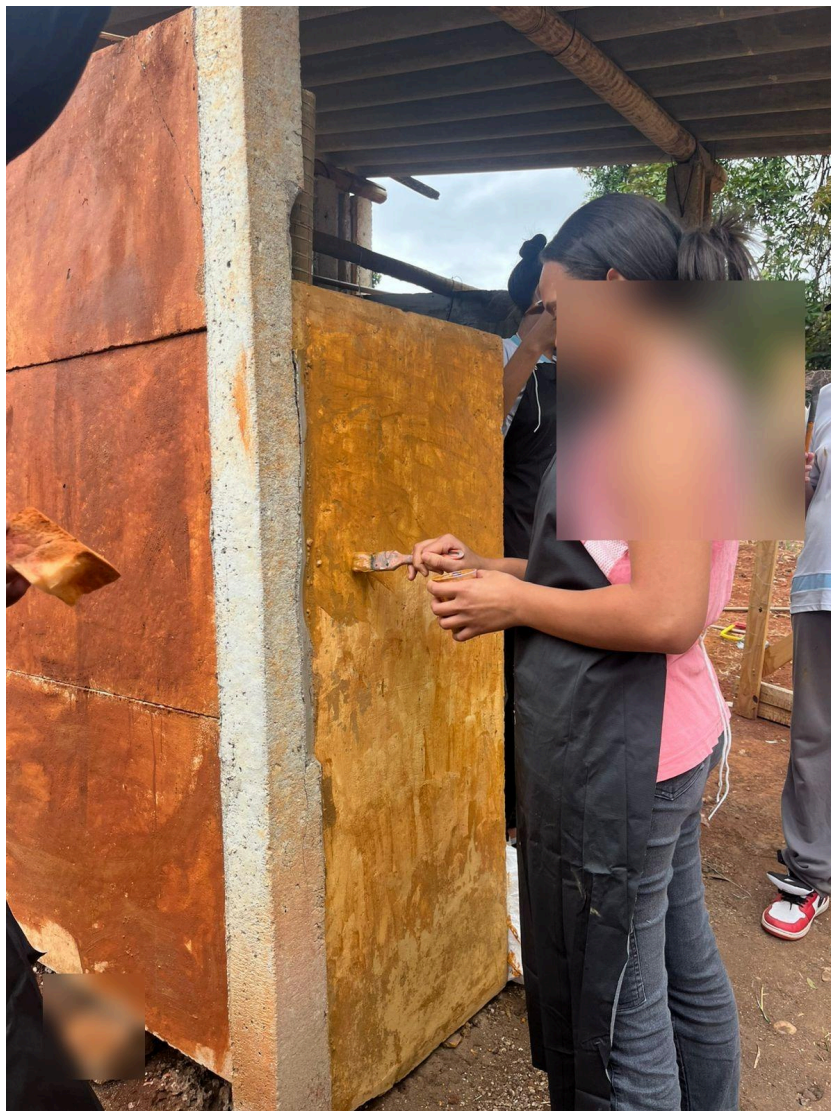
A Figura 19 a seguir documenta: estudante aplicando Tinta de Terra sobre estrutura de madeira do galinheiro durante a oficina de bioconstrução.
