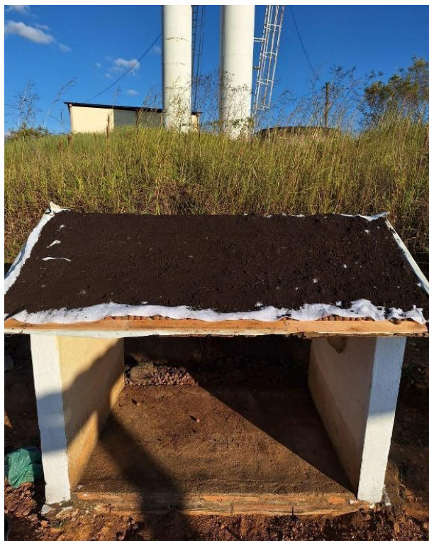
Figura 5 – Aplicação de camada de solo sobre a manta geotêxtil no sistema de telhado verde.
