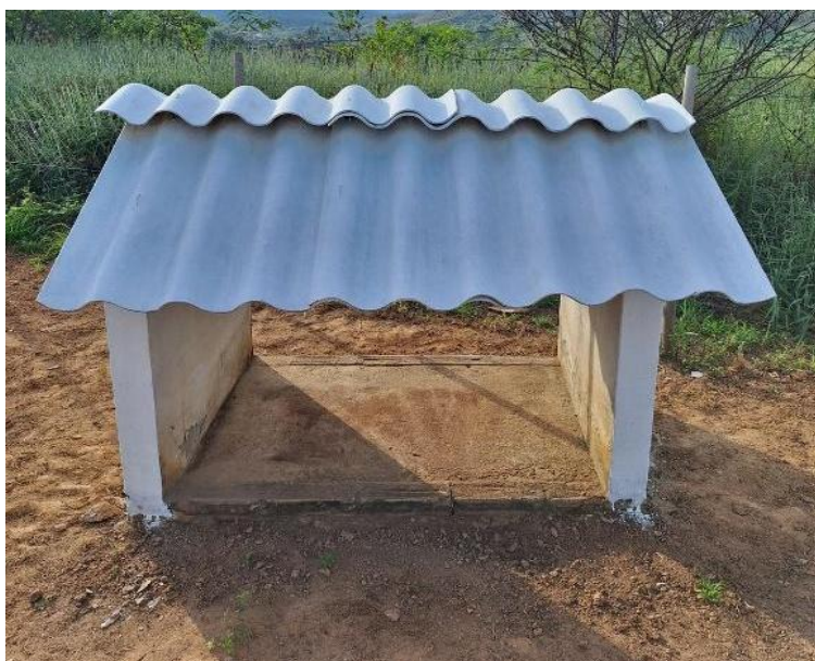
Figura 3 – Telhado de fibrocimento com aplicação de manta líquida acrílica emborrachada e reflexiva sobre a superfície da cobertura.
