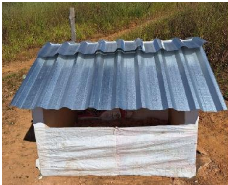
Figura 2 – Telhado metálico galvanizado.
