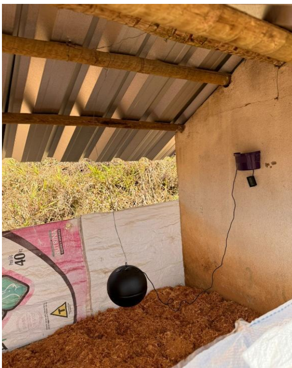
Figura 14 - Sistema de monitoramento de temperatura
