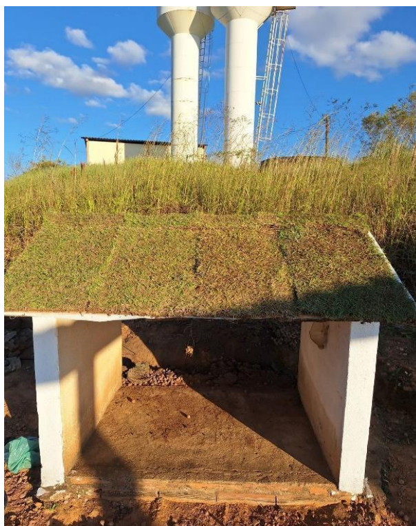
Figura 6 - Telhado verde com cobertura vegetal (grama) após implantação do sistema.
