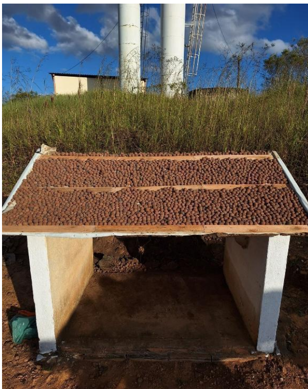
Figura 4 - Camada de argila expandida aplicada sobre a lona impermeabilizante no telhado verde.
