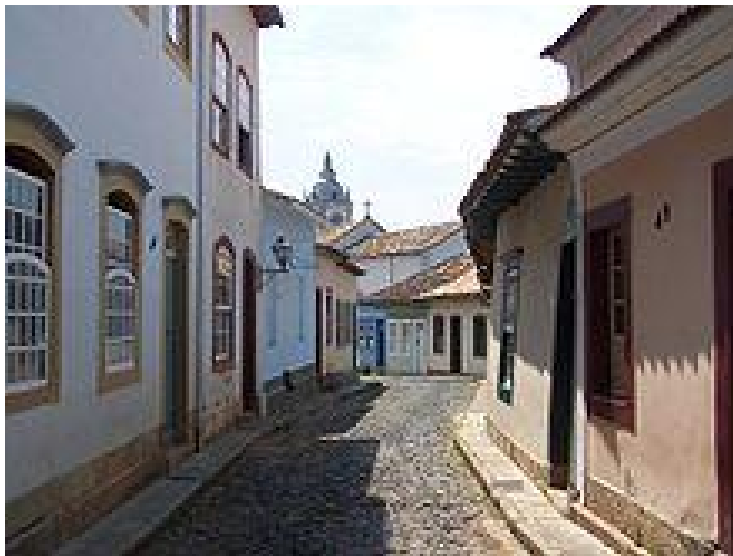
Rua Santo Antônio (Caminho dos Bandeirantes). Conhecida como a "Rua das Casas Tortas".
