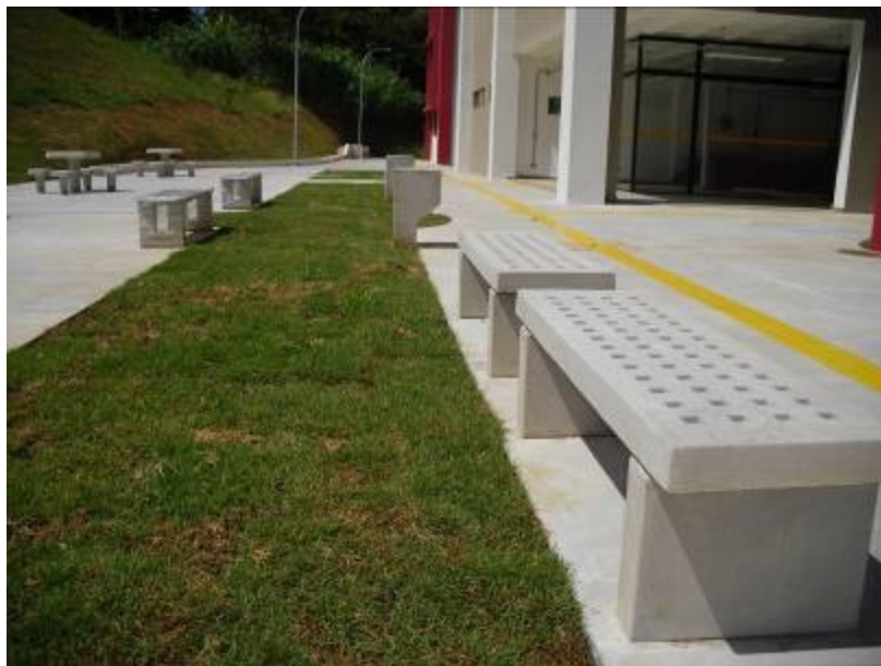
detalhes bancos, sinalização de piso tátil, piso concreto
