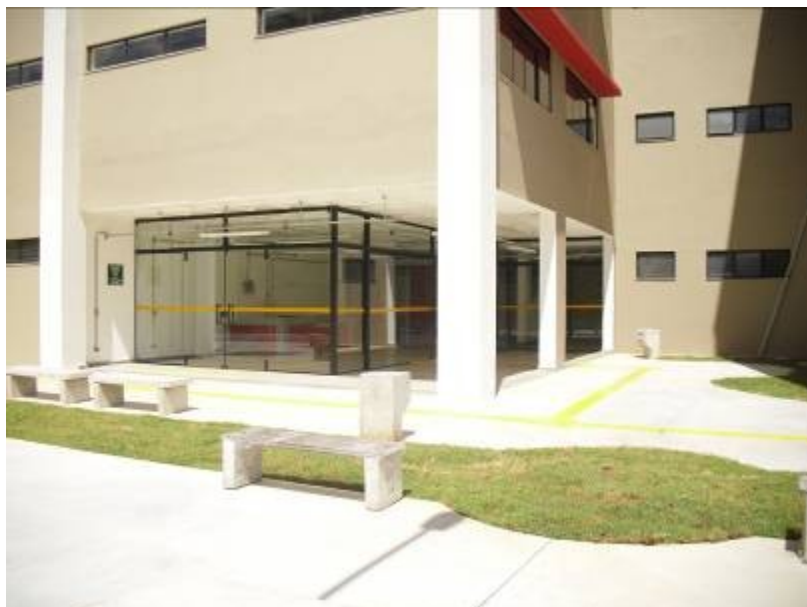
entrada do prédio, detalhes bancos, sinalização de piso tátil, piso de concreto
