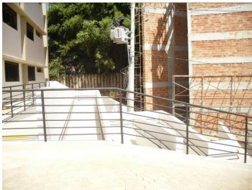
rampa de acesso portadores de necessidades especiais
