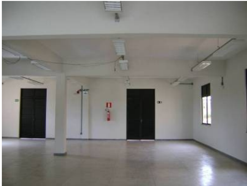
Construção de prédio para a Cantina no Campus Dona Lindú
