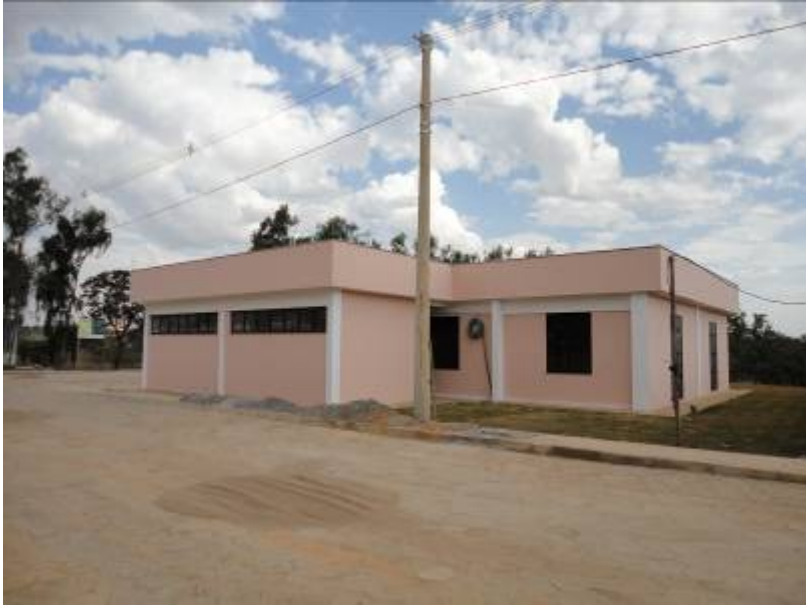
Construção prédio Cantina no CSL - 2ª etapa. 4ª medição
