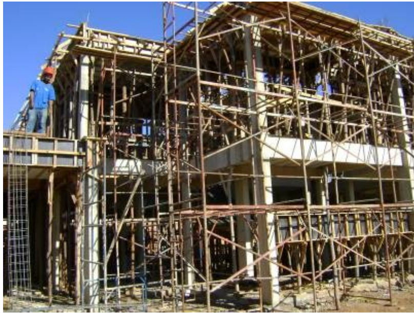
Construção de prédio para o curso de Farmácia - 1ª etapa
