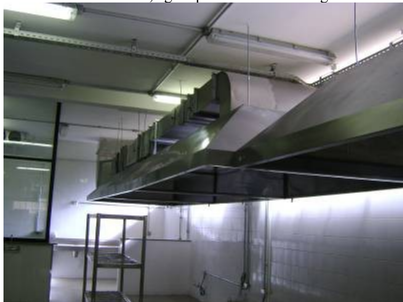
Instalação de sistemas de exaustão, água quente e câmaras frigoríficas no RU – CTAN
