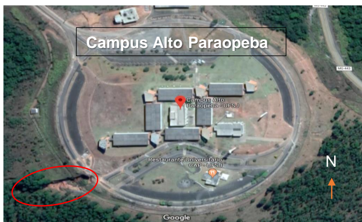
Figura 1. Localização da voçoroca no CAP. Fonte: Adaptado de Google Earth , 2018.
