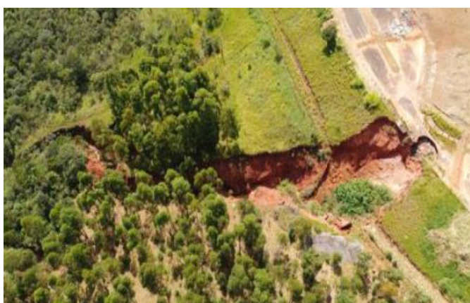
Figura 5. Vista aérea da erosão em 2018 (Souza, 2018).
