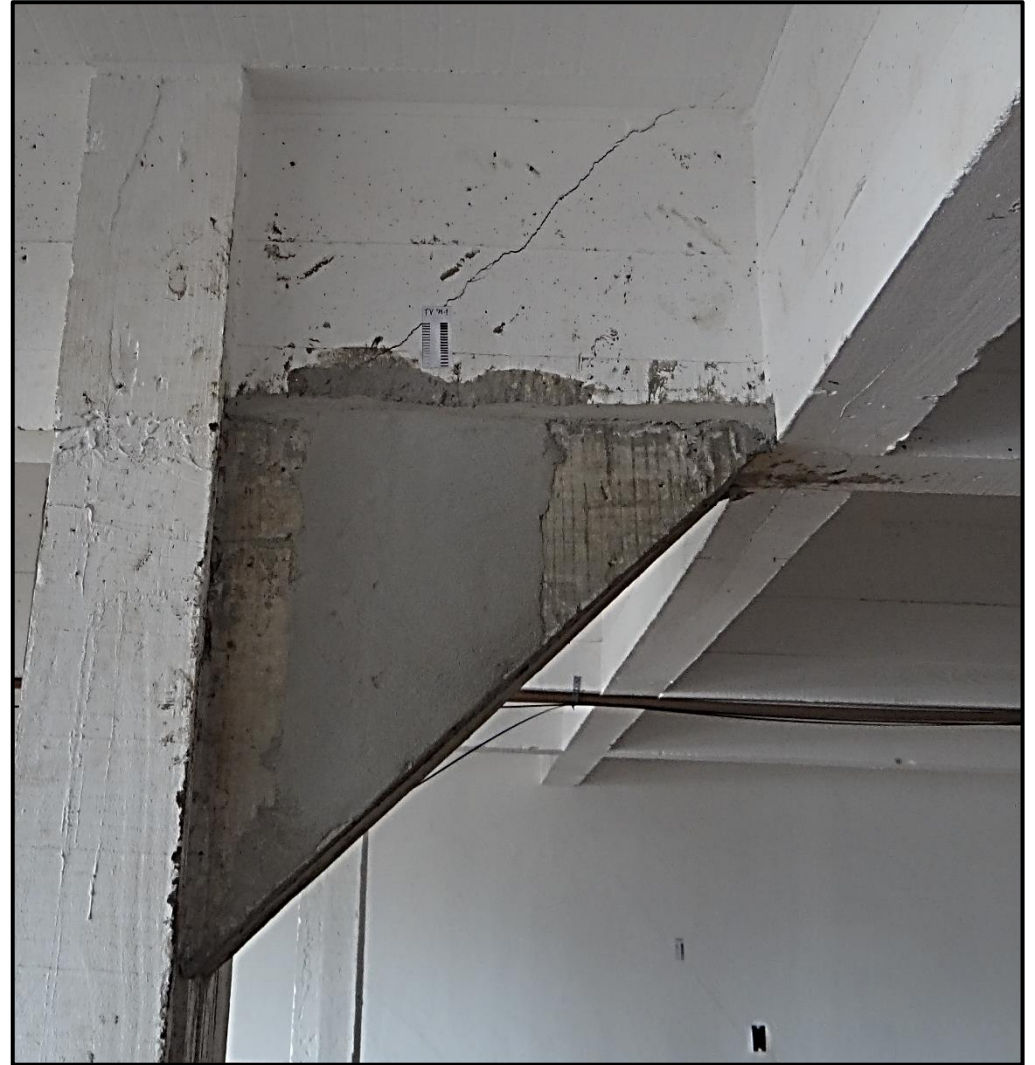
Fissura em viga em região de apoio devido ao cisalhamento em subsolo -1.
