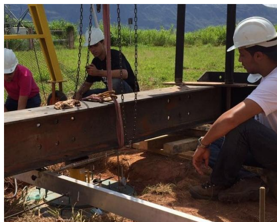
Figura 4. Montagem da prova de carga.
