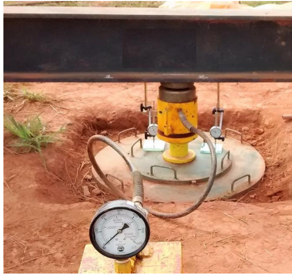
Figura 5. Prova de carga sapata sobre Mini-RAP.
