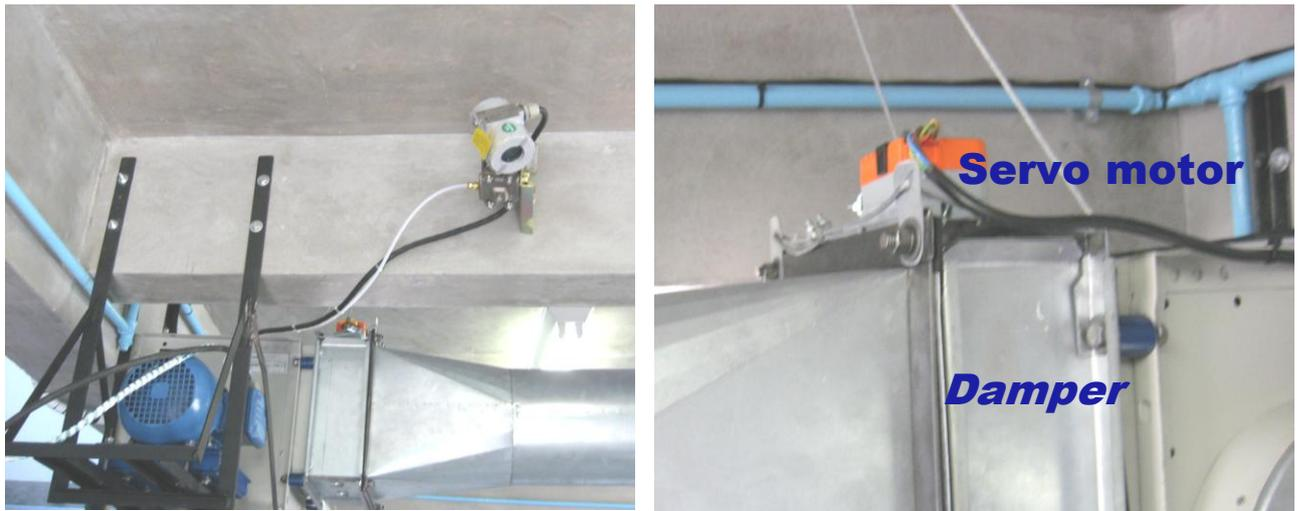
Figura 13. Detalhes da montagem da *damper* com o seu servo motor
