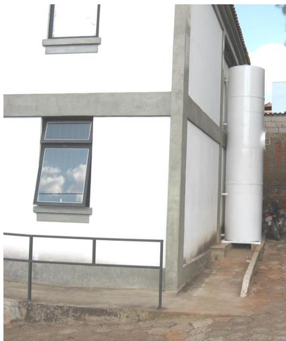
**Figura 6. Vista do Reservatório de Sucção e Recalque/Regularização**
