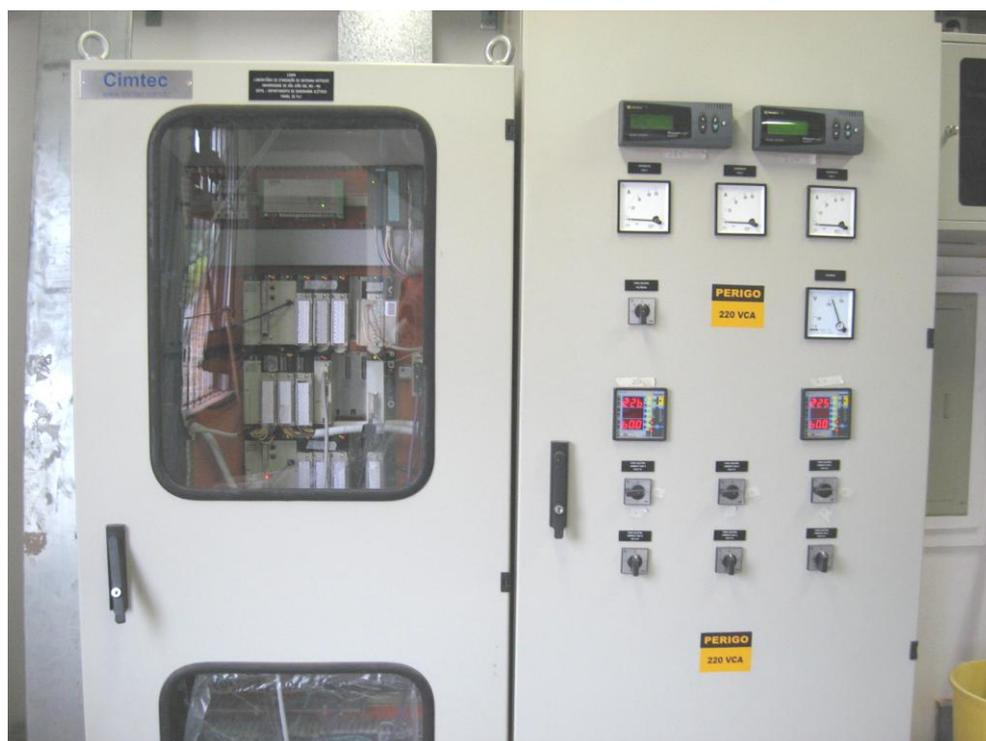
**Figura 4. Vista frontal externa do Painel do PLC e do CCM**
