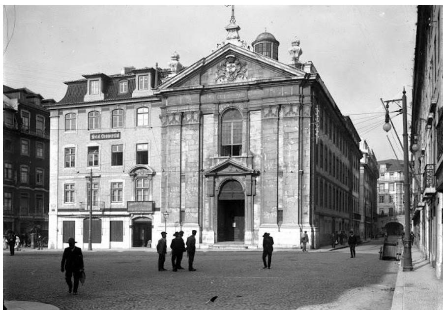
Figura 2 - Igreja do Corpo Santo (foto antiga)
