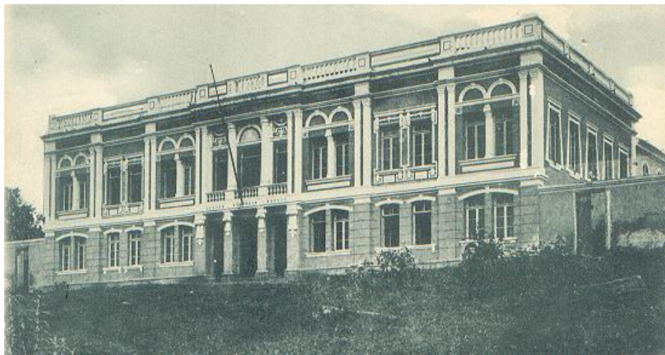
Figura 4 - Prédio do Asilo São Francisco de Assis e do Ginásio após reforma, por volta de 1918.
