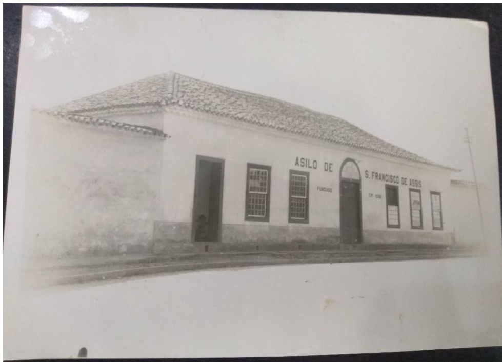
Figura 2 - Prédio do Asilo de São Francisco de Assis, s/d
