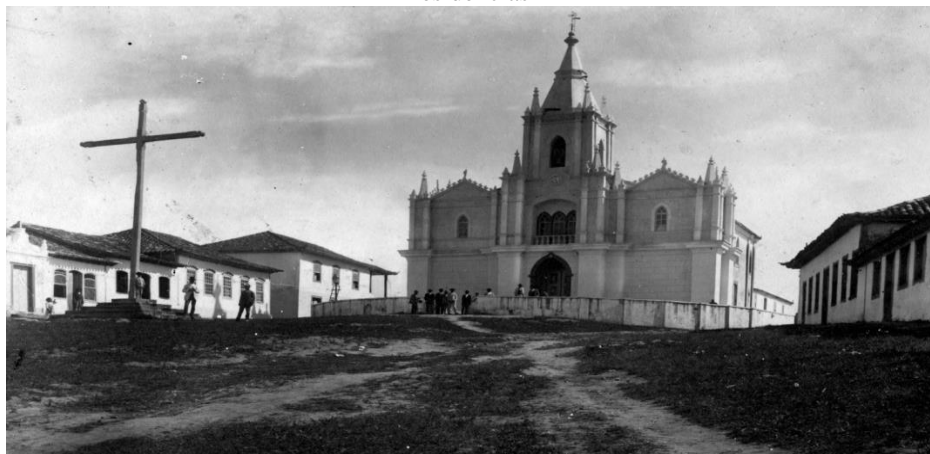
Figura 2: Fotografia da antiga igreja matriz de Nossa Senhora da Penha no topo da laje e em torno dela algumas residências
