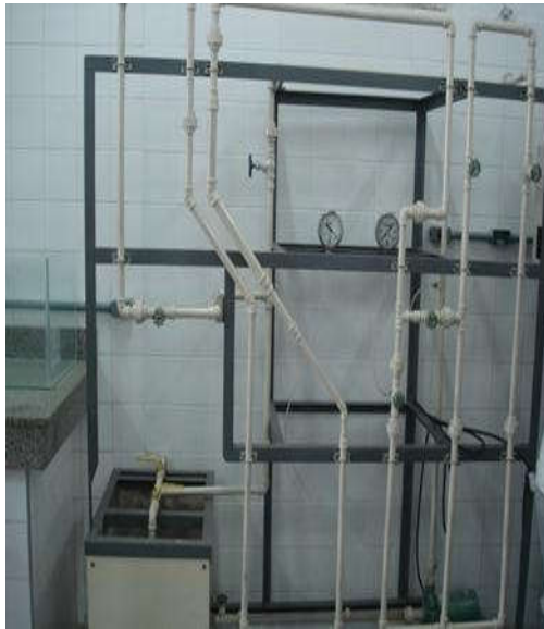
Fig.5: Bancada de Cavitação em tubulação
