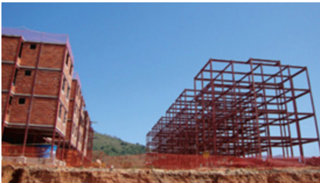
Figura 3 – Sistema de estrutura metálica
