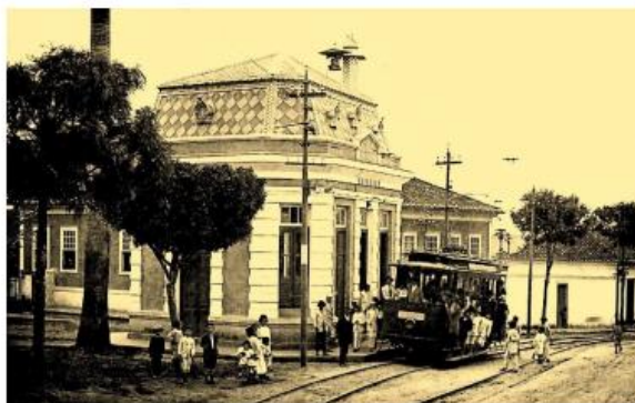
A antiga estação do bonde (1911). Ficava à Praça Barão de Lavras, entre a Rua Sant'Ana e a Igreja de Nossa Senhora do Rosário. A estação e a própria praça foram suprimidas em 1942, para a construção de uma agência bancária.
