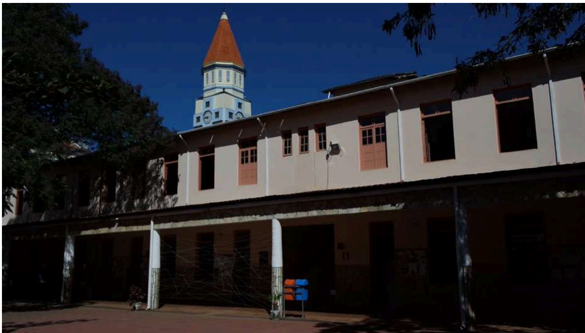
Figura 7 - Fotografia do autor, Campus Dom Bosco, UFSJ - pátio central, 2015.
