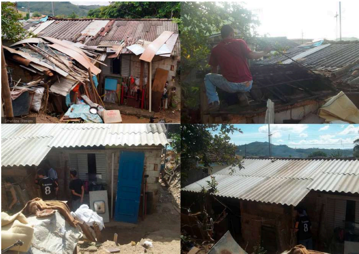
Figuras 22 - Retirada de entulhos, reforma da cozinha e troca de telhado em residência na rua Ângelo Tirapeli. Imagens do coletivo Abraçá. 2015
