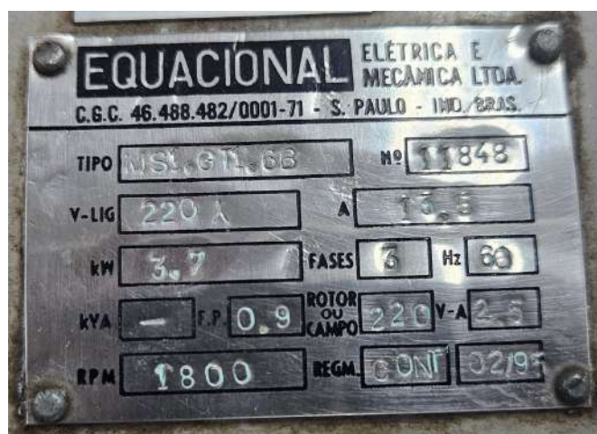
Figura 3.7 – Placa de identificação do gerador síncrono utilizado.
