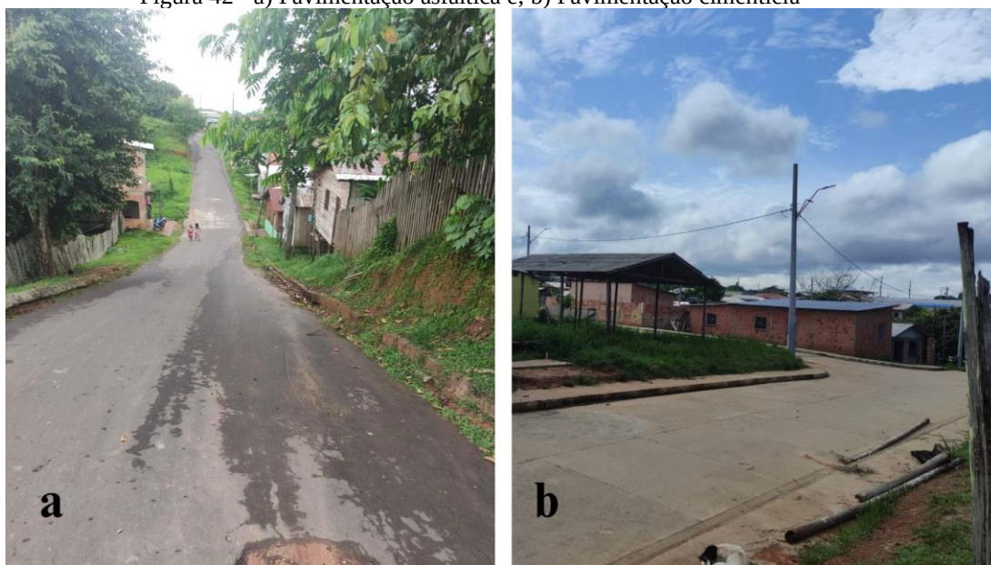
Figura 42 - a) Pavimentação asfáltica e; b) Pavimentação cimentícia
