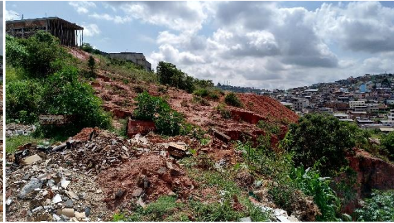
Figura 12: Avanço da erosão perto de residências com presença de lixo e entulho. Fonte: Levantamento em campo, 2018.
