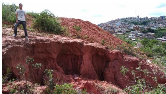
Figura 4: Zona de avanço da erosão linear. Fonte: Levantamento em campo, 2018.
