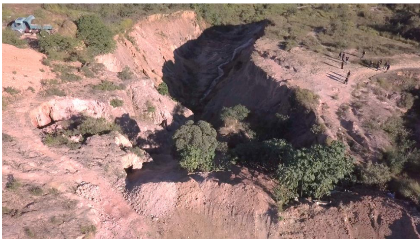
Figura 06: Flagrante do despejo de entulho da caçamba de um caminhão dentro da voçoroca. Fonte: Levantamento em campo, 2018.
