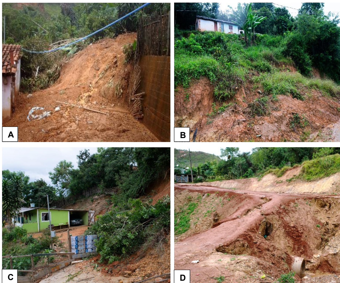
Figura 20: Bairro Banheira com ocupação de áreas suscetíveis e movimentos de massa.
