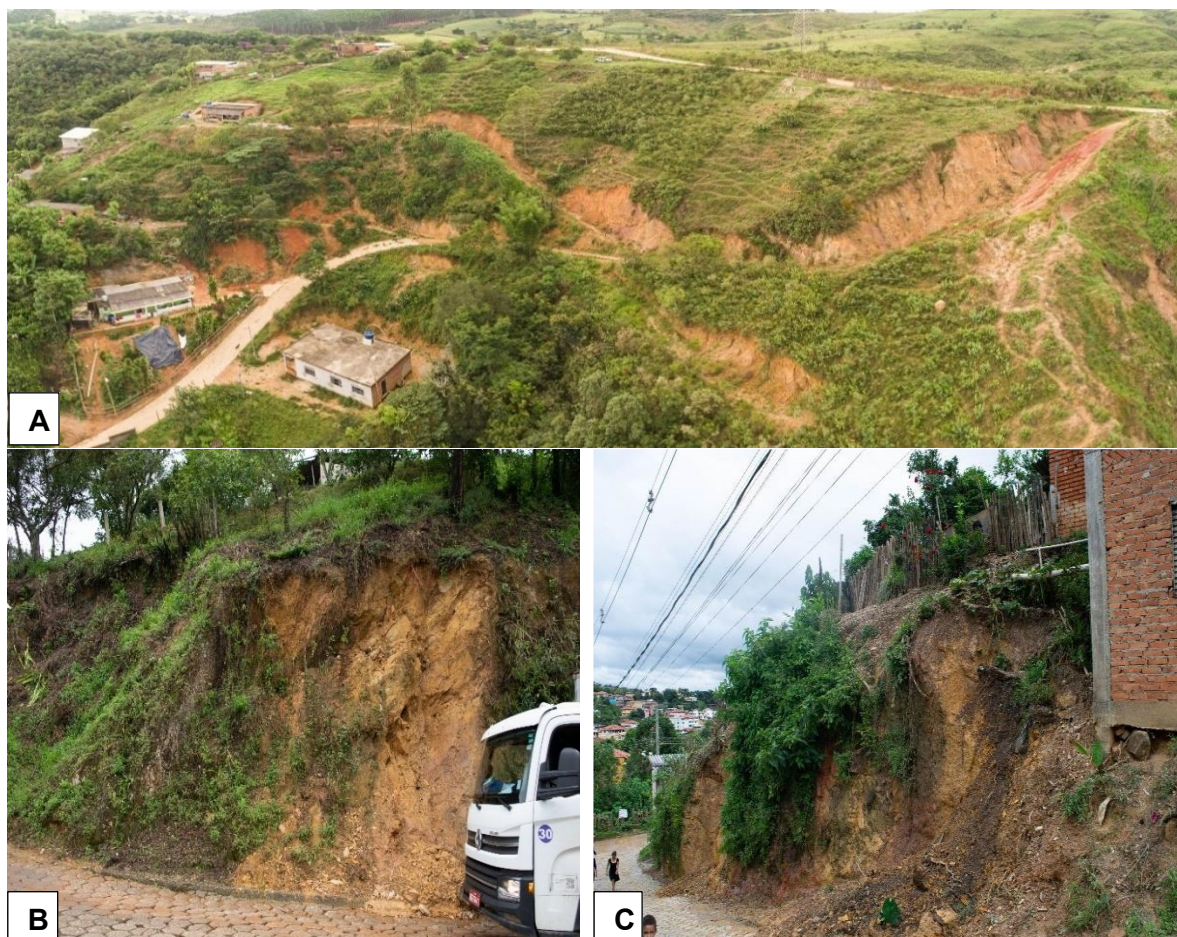
Figura 21: Movimentos de massa e ocupação desordenada no Bairro Quebra Castanha.
