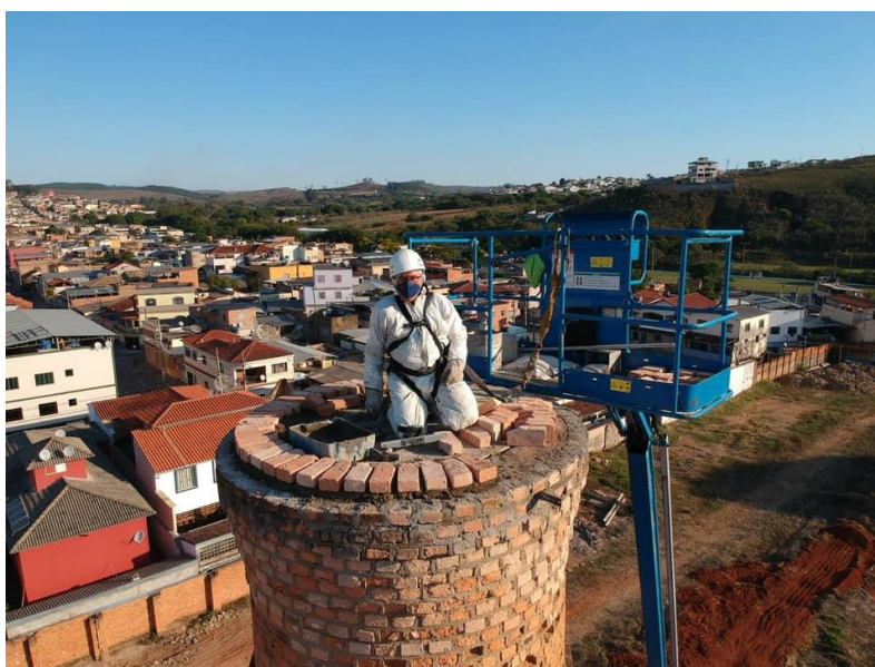
Figura 37: Fotografia do processo de construção do Pátio Matosinhos.
