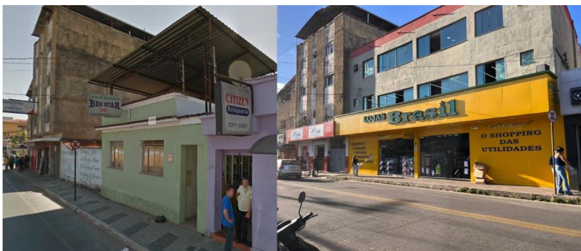
Figura 45: Casa e lote situados na Av. Josué de Queiros, próxima ao Pátio Matosinhos (2011) e atual Lojas Brasil (2024)
