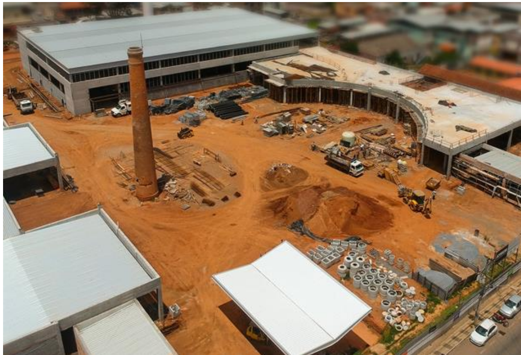
Figura 31: Fotografia do processo de construção do Pátio Matosinhos.
