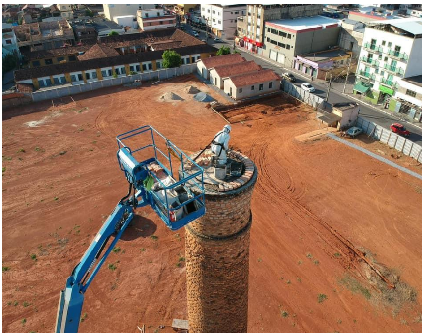
Figura 34: Fotografia do processo de construção do Pátio Matosinhos. Vista aérea.
