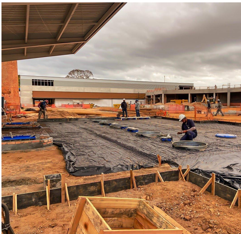
Figura 32: Fotografia do processo de construção do Pátio Matosinhos.
