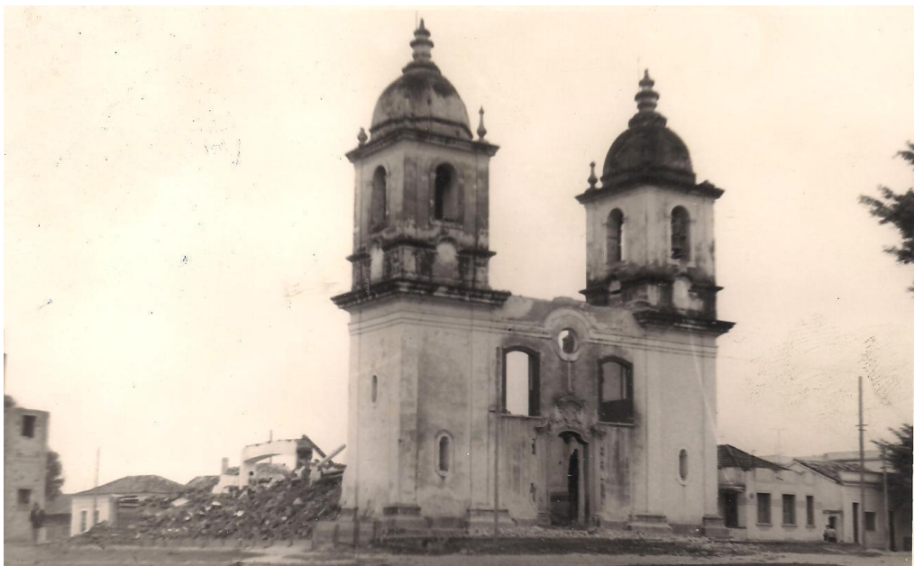
Figura 20: Fotografia da demolição da Igreja do Senhor Bom Jesus de Matosinhos. (1970)
