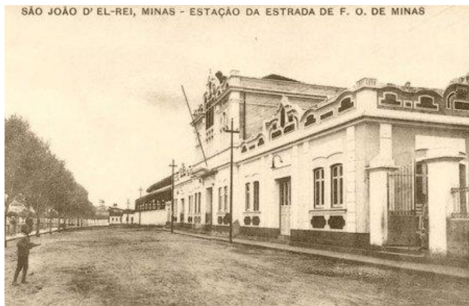
Figura 10: Estação de São João del-Rei (1920).
