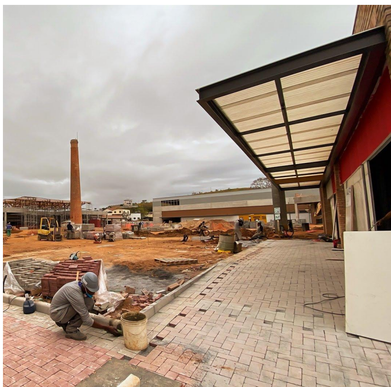
Figura 33: Fotografia do processo de construção do Pátio Matosinhos.
