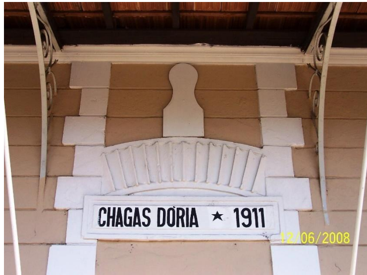
Figura 15: Foto do detalhe da Estação de Chagas Dória. (2008)
