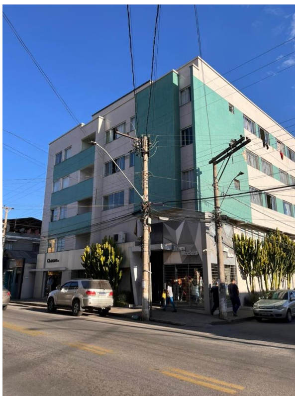
Figura 25: Fotografia do prédio onde se situava o Castelinho. Av. Josué de Queiróz
