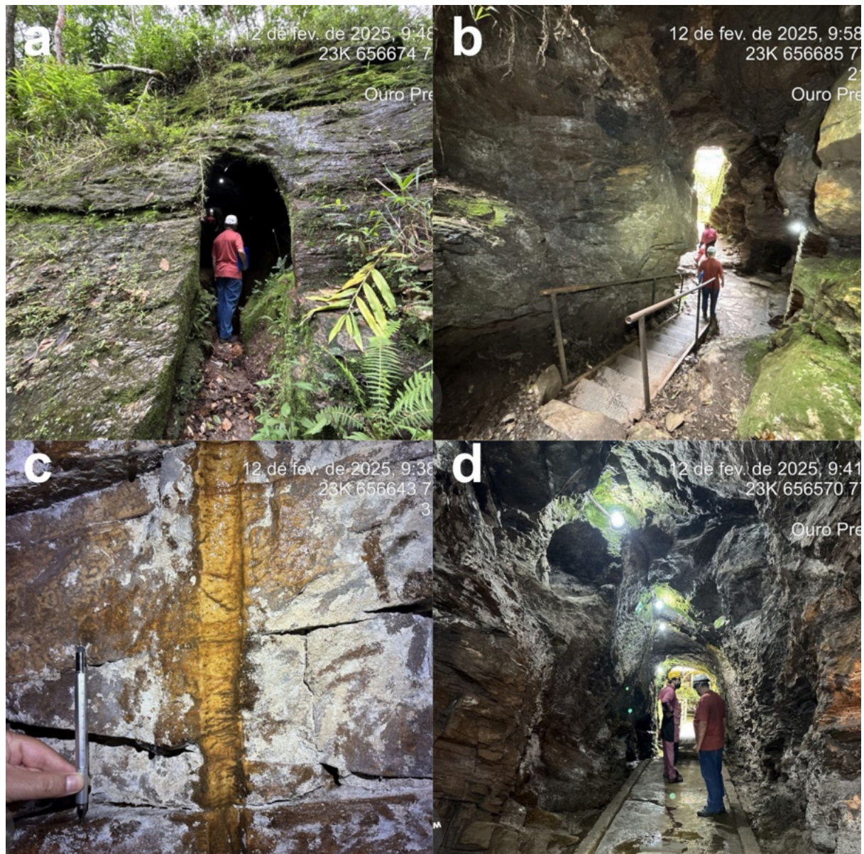
Figura 17 - Minas do Palácio Velho. a Entrada da mina escavada em rocha. b Galeria com escadaria e corrimão adaptados para visitação, indicando intervenções recentes para segurança e acesso. c Furo de sondagem, sem datação precisa. d Galeria interna com iluminação artificial e afloramentos rochosos irregulares
