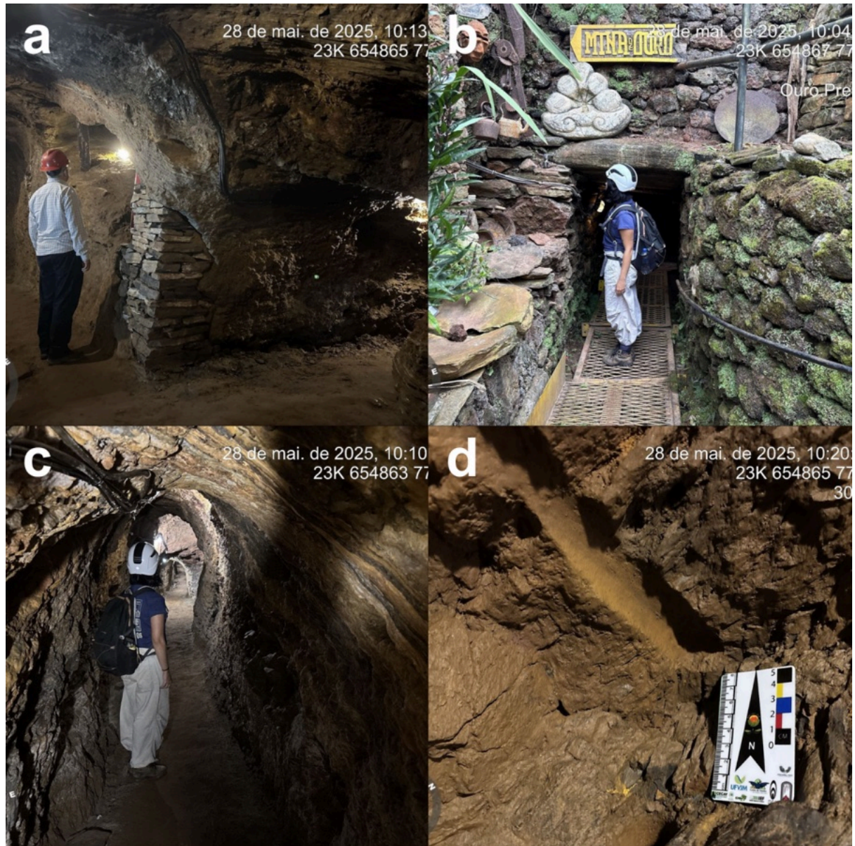
Figura 11 - Mina do Chico Rei. a Trecho interno da galeria subterrânea, evidenciando escavação manual em rocha e estrutura de sustentação em alvenaria atual de pedra seca, utilizada para estabilização do teto para segurança turística. b Entrada principal da mina, inserida em estrutura de contenção em pedra, com passarela metálica e elementos de adaptação para visitação controlada. c Galeria interna de seção irregular, com paredes e teto marcados por planos de desmonte e marcas de ferramentas ligadas às atividades minerárias pretéritas. d Detalhe da superfície rochosa da galeria, destacando marcas lineares associadas ao processo de escavação manual
