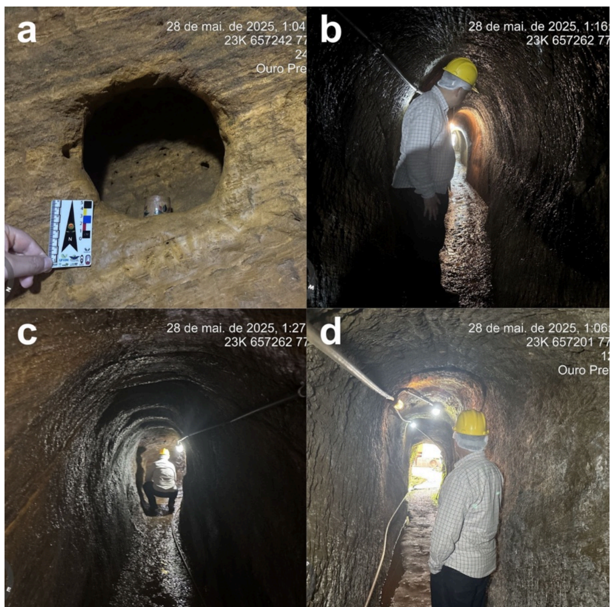
Figura 18 - Mina Santa Rita. a Estrutura escavada na rocha, denominada bucho segundo o proprietário da mina, utilizada como compartimento para depósito do ouro durante o processo de lavra. b Galeria estreita e alongada, com piso úmido, evidenciando o método manual de escavação e as condições de circulação no interior da mina. c Vista longitudinal da galeria, destacando sua seção reduzida e a continuidade do túnel. d Trecho da galeria próximo à saída, com iluminação instalada, indicando adaptações contemporâneas para visitação e segurança
