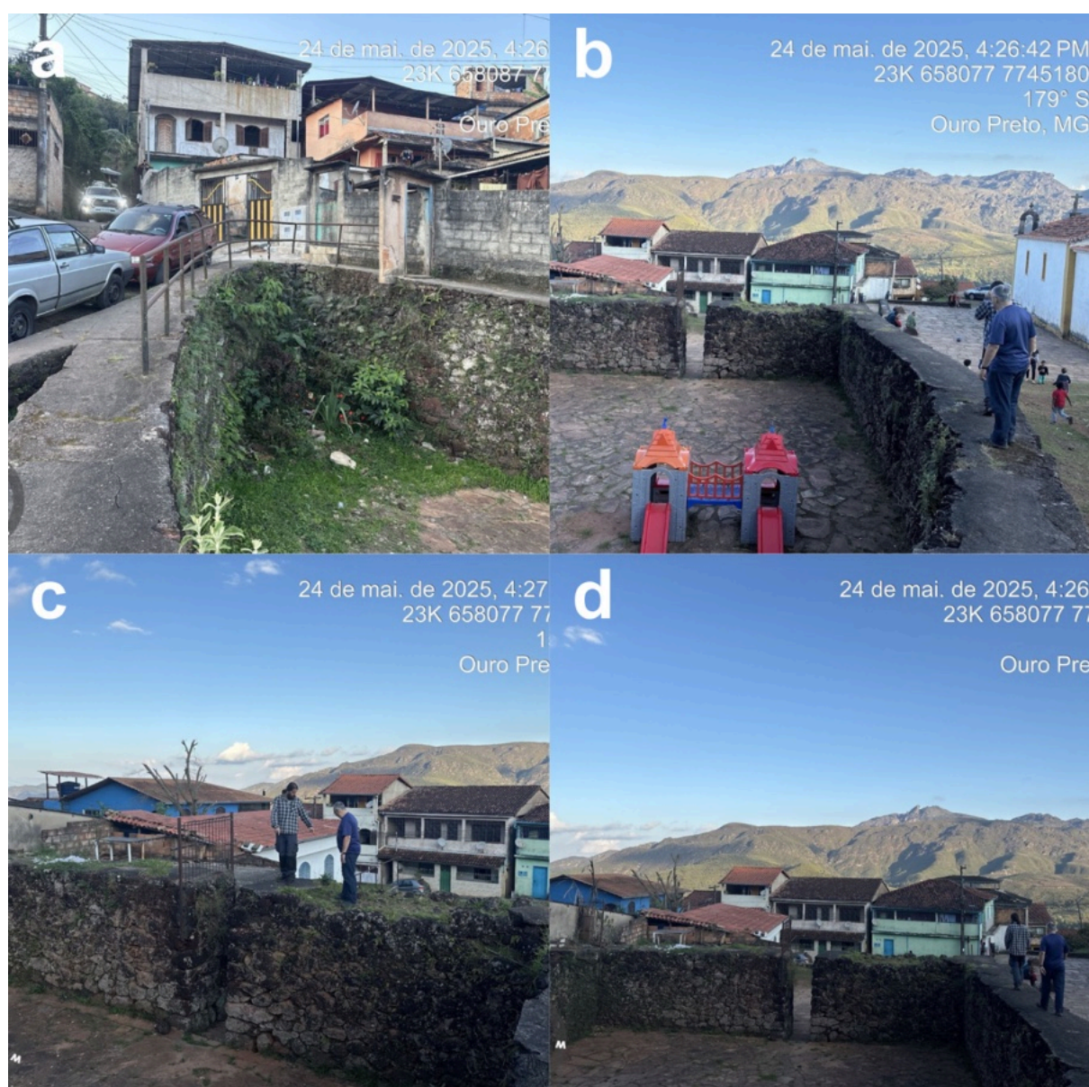
Figura 22 - Mundéu localizado em área urbana no Morro da Piedade. a Vista lateral da estrutura, evidenciando o desnível do terreno, os muros em alvenaria de pedra e sua
