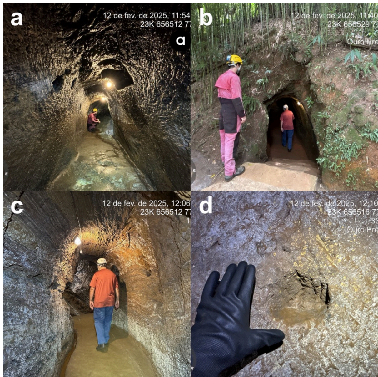
Figura 13 - Mina do Bijoca. a Galeria subterrânea escavada, com seção estreita e paredes irregulares, presença de umidade no piso. b Acesso externo à mina, com abertura escavada em encosta natural, evidenciando a adaptação do sítio ao relevo local e o controle de entrada para visitação. c Trecho interno de galeria com piso argiloso úmido. d Detalhe da superfície rochosa da galeria com reentrância escavada manualmente, interpretada, segundo informações dos funcionários da mina, como estrutura de apoio para ferramentas, iluminação ou outros utensílios utilizados durante as atividades minerárias
