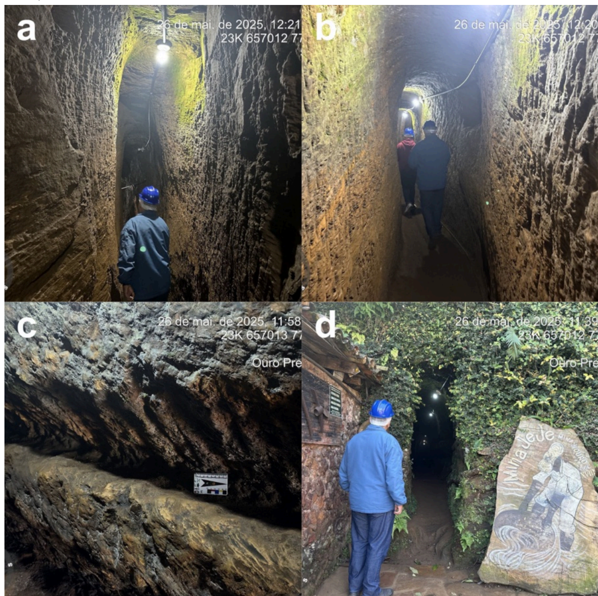
Figura 15 - Mina do Jeje. a Galeria subterrânea estreita, com paredes escavadas manualmente, evidenciando marcas das ferramentas utilizadas na mineração colonial e sistema atual de iluminação para visitação. b Trecho da galeria principal durante percurso guiado, destacando a circulação dos visitantes e a adaptação do espaço para uso turístico seguro. c Detalhe da rocha encaixante no interior da mina, com estruturas resultantes da escavação manual que, segundo os guias locais, também poderiam ter servido como apoio
