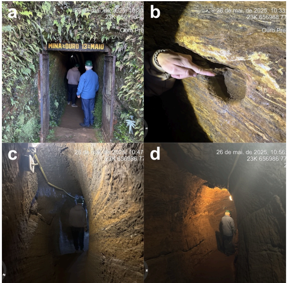
Figura 14 - Mina 13 de Maio. a Entrada principal da mina, com portal escavado em encosta natural. b Detalhe de reentrância escavada manualmente na parede da galeria, interpretada como nicho funcional associado ao apoio de ferramentas, iluminação ou outros utensílios utilizados durante a atividade minerária. c Trecho interno de galeria estreita, com paredes irregulares. d Vista longitudinal de galeria subterrânea, destacando a continuidade do conduto, a morfologia das paredes e teto e a iluminação instalada para uso turístico e técnico
