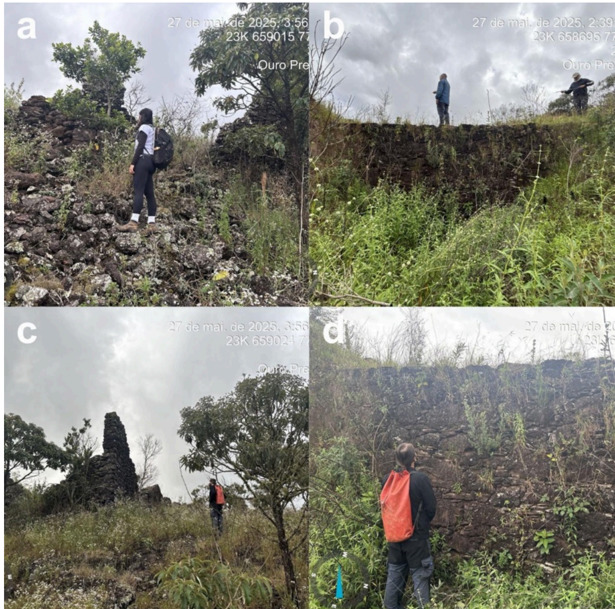
Figura 21 - Estruturas em área periurbana dos bairros Taquaral e Piedade. a Conjunto de estruturas construtivas em alvenaria de pedra, parcialmente colapsadas e recobertas por vegetação, associadas a edificações de apoio às atividades minerárias. b Estrutura linear em alvenaria de pedra, interpretada como muro de contenção, implantada no limite superior do terreno, possivelmente destinada à estabilização do talude e ao controle de materiais. c Vista parcial de estrutura construtiva em alvenaria de pedra, possivelmente relacionada a edificações auxiliares, evidenciando o grau de arruinamento e a integração com a vegetação local. d Detalhe do muro de contenção, permitindo observar a técnica construtiva em pedra e o estado de conservação da estrutura, com presença de colonização vegetal e processos de degradação
