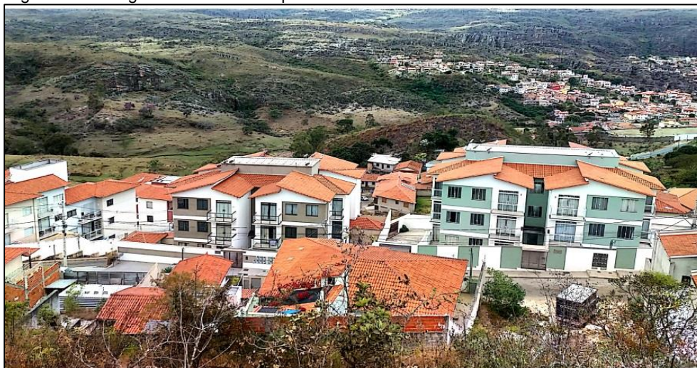
Figura 21 - Fotografia dos novos empreendimentos do Bairro Pedra Grande
