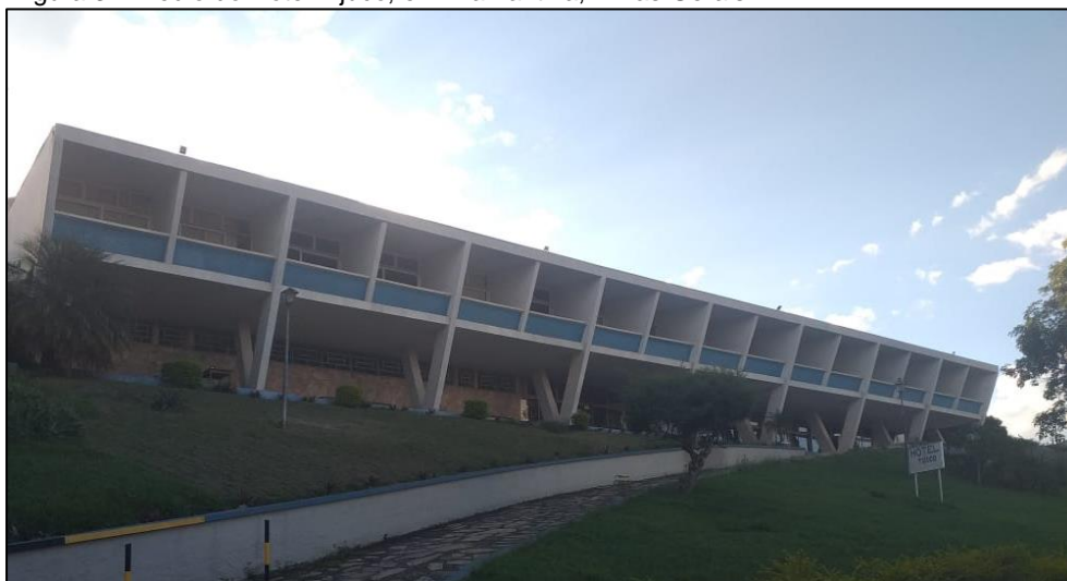
Figura 3 - Prédio do Hotel Tijuco, em Diamantina, Minas Gerais
