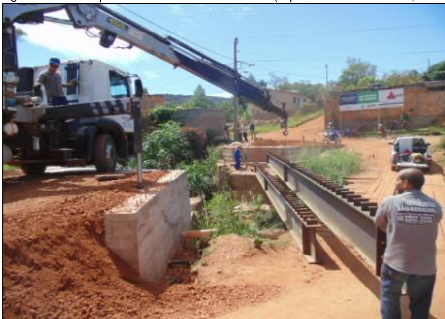
Figura 18 - Ponte que dá acesso ao Maria Orminda (expansão do bairro Palha).
