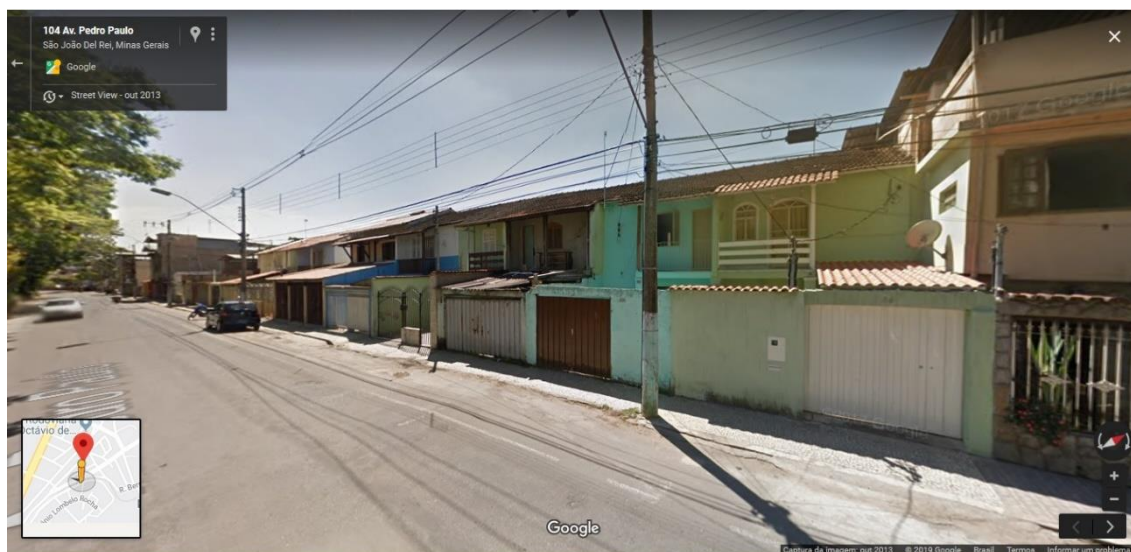
Figura 12. “Casas altas” atualmente
