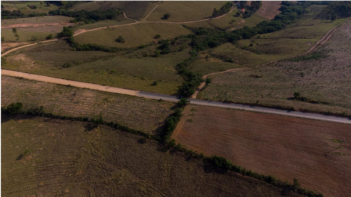
Figura 19. Asfaltamento da Via de Acesso ao Distrito de Emboabas (2023) Fonte: Fotografia aérea recolhida em trabalho de campo (2023)
