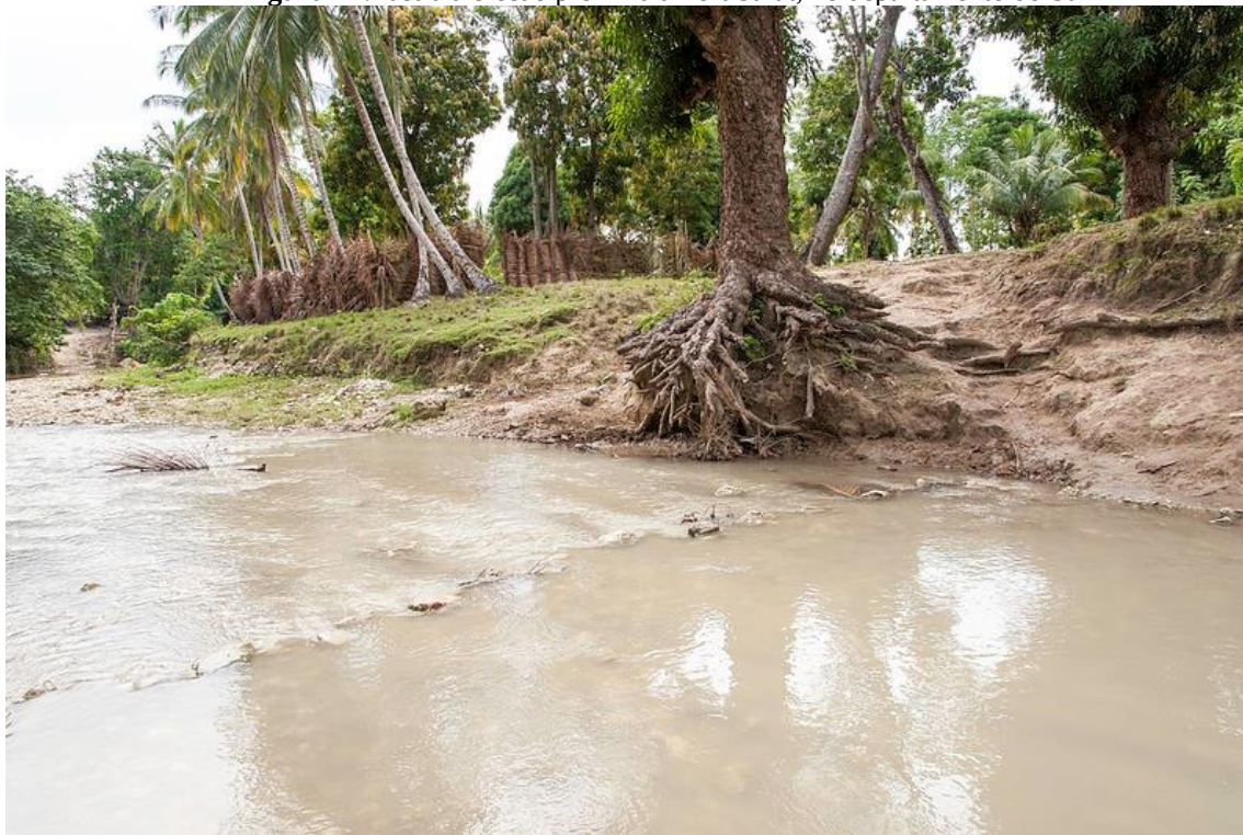
Figura 12: ilustra a erosão próxima a Port Salut, no departamento do Sul
