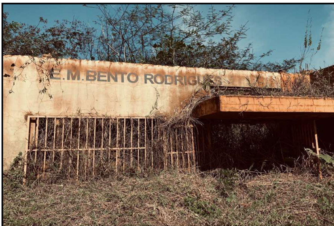
Figura 11- Escola Municipal de Bento Rodrigues após a tragédia
