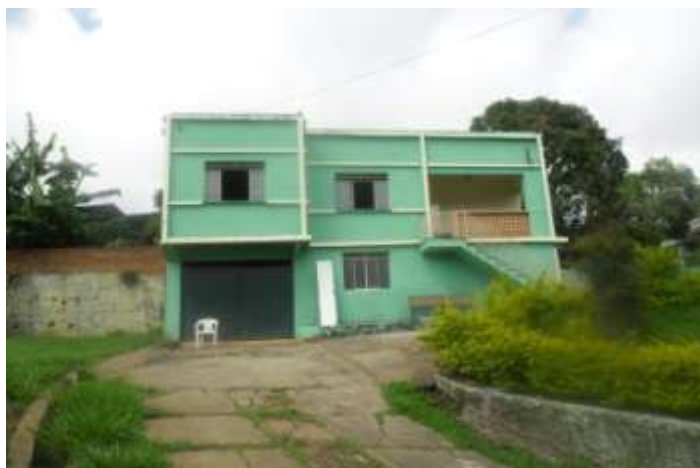
Figura 1: exibe a fachada do serviço. Observa-se a presença de escada, dificultando o acesso dos usuários que compareciam às consultas e avaliações da equipe.
